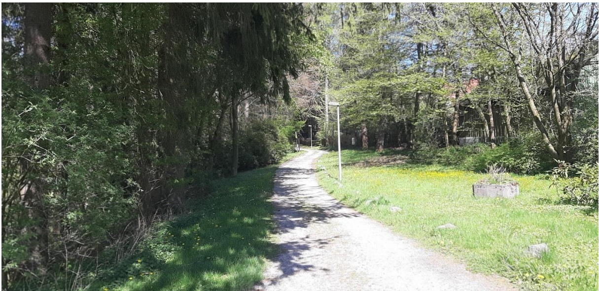
Abbildung 5: Bestehender wassergebundene Erschließungsweg (eigene Aufnahme, April 2025)
