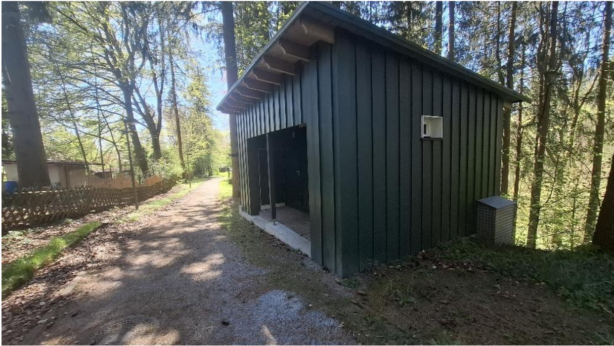
Abbildung 8: Bestehendes Sanitärgebäude (eigene Aufnahme, April 2025)
