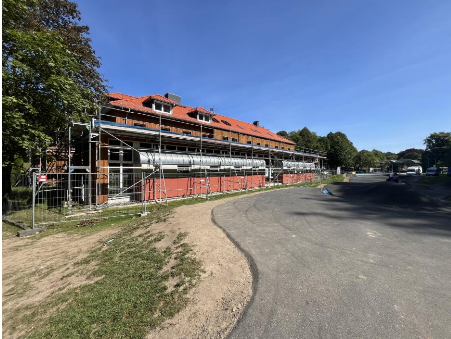
Foto 1: Blick nach Westen auf das Hauptgebäude mit Einrüstung für Sanierungsarbeiten.
