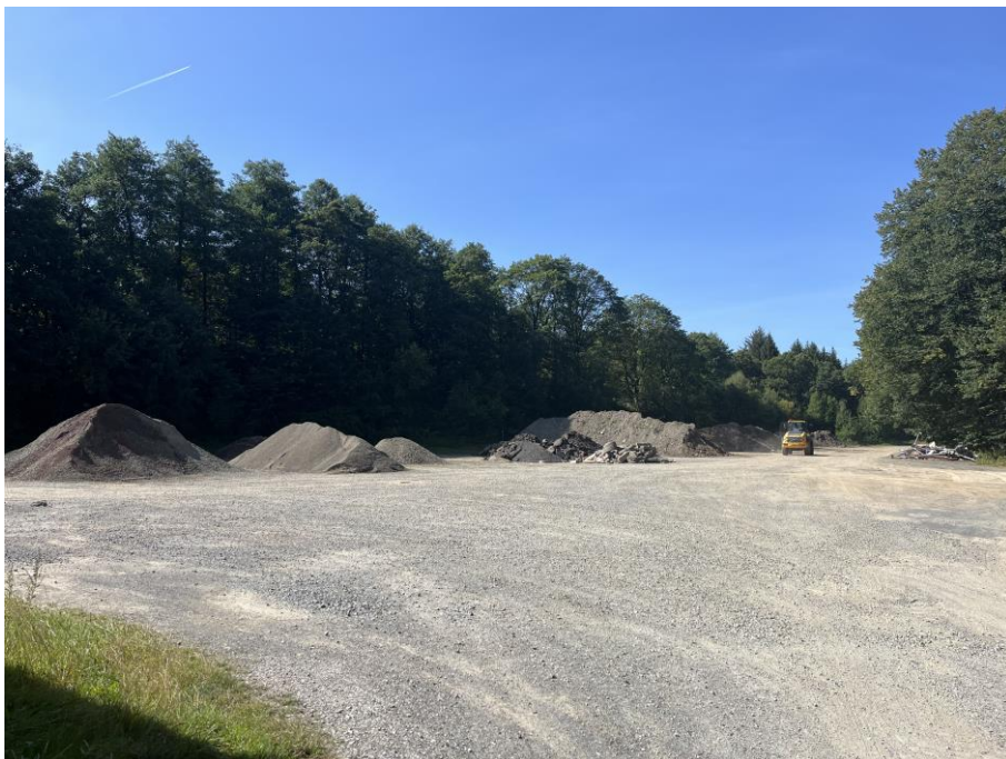
Foto 6: Freifläche westlich des Bahnhofsbauwerkes. Mit Schotter belegte Fläche und Ablagerungsort für Baustoffe (RC-Material).
