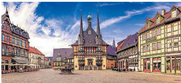
Erstrahlt in saniertem Glanz: der Marktplatz von Wernigerode
