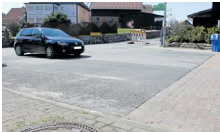
Im Mai und Juni soll hier nichts mehr gehen: Die Kreuzung Alte Fuhrherrenstraße/Mittelweg wird wegen Kanal- und Leitungsarbeiten komplett gesperrt, Buntenbock zerfällt in zwei Teile. Fotos: Bruns
